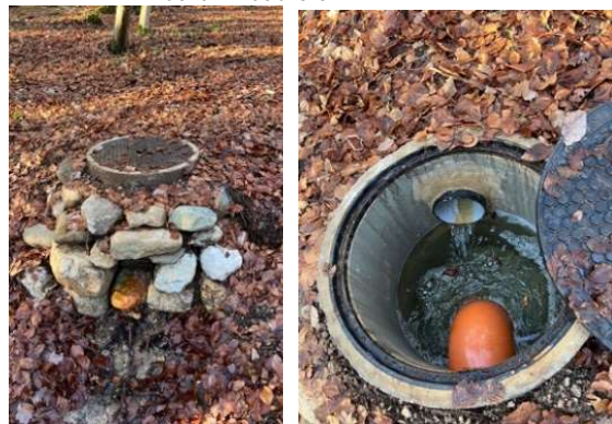
Mise aux normes du trop-plein de la source de la « Vuablière »
