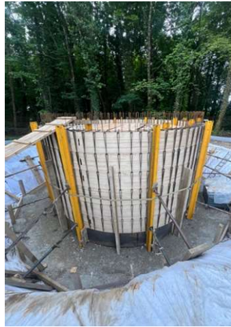
Construction du puits par havage
