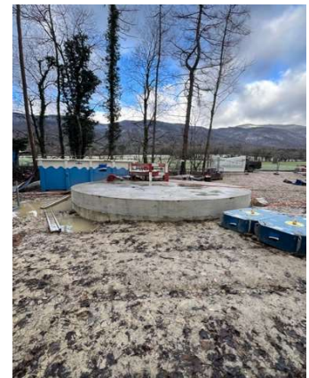
Etat des travaux fin 2024
