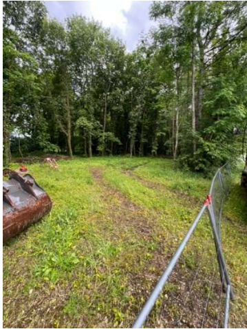
Ouverture du chantier
