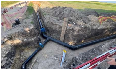
Pose des conduites
