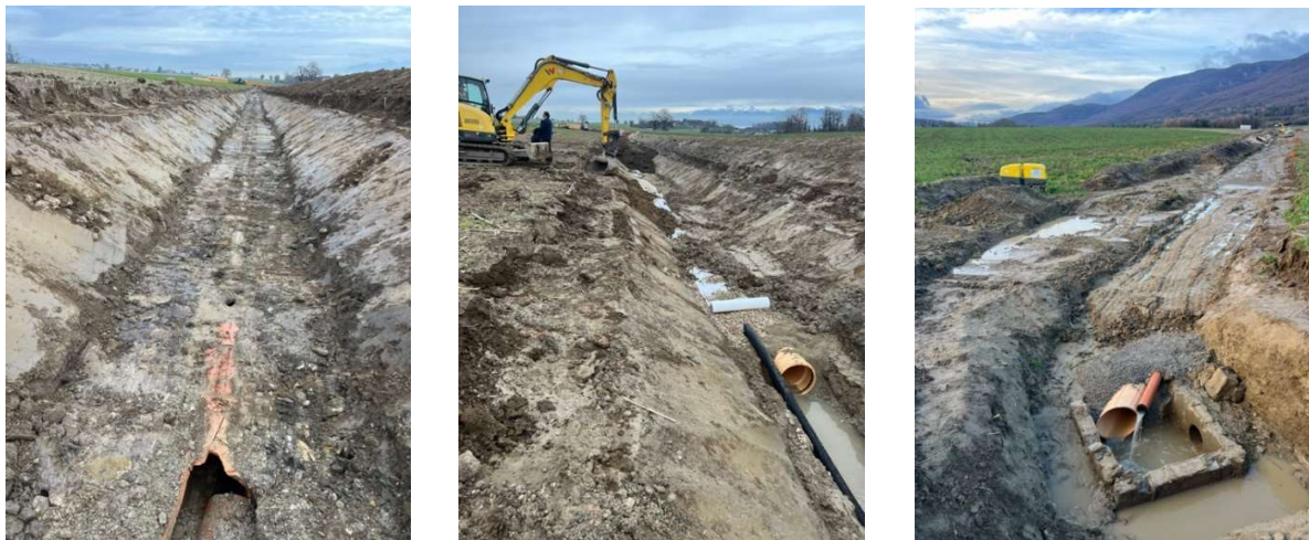
Découverte du collecteur existant et pose de la nouvelle conduite
