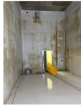
Vidange et nettoyage du réservoir du Bucley
