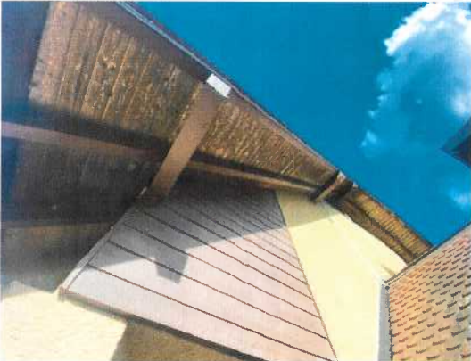
PHOTO NR 3 Peinture avant toit en blanc. Poutre de la charpente apparente en Brun.
