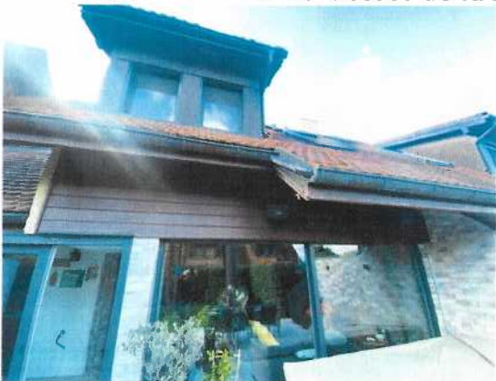
PHOTO NR 2 Bois brun au-dessus de la fenêtre sera modifié par de l'isolation.
