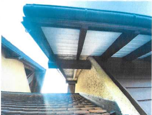
PHOTO NR 4 Peinture avant toit en blanc. Poutre de la charpente apparente en Brun.
