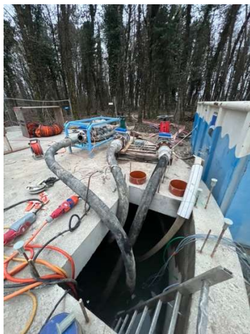
Essais de pompage février 2025
