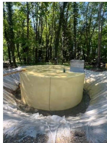
Étanchéité du puits
