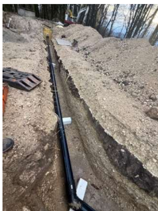
Pose des conduites
