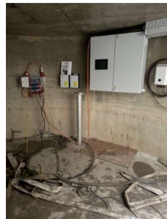
Pose des tableaux de commande
