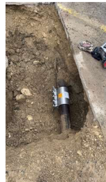
Détection et réparation de la conduite
